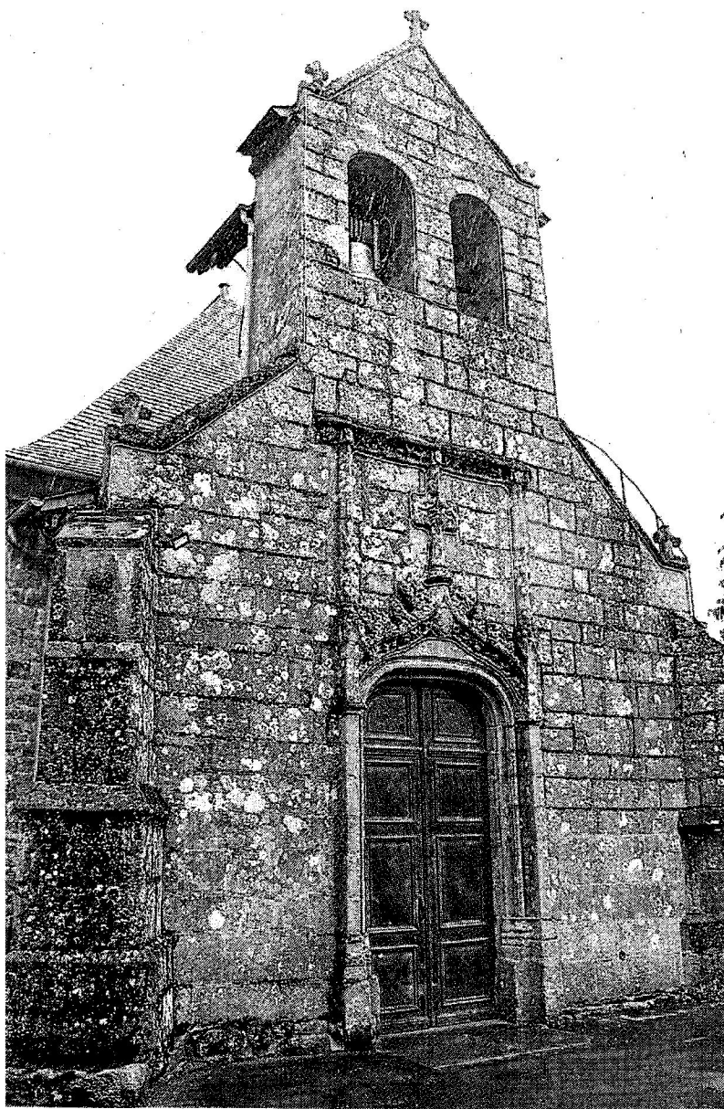
La façade est l'élément architectural le plus intéressant, c'est d'ailleurs, avec Villamée, le seul clocher-mur de façade qu'il reste dans la région. La finesse de la porte contraste avec la robustesse du mur.
